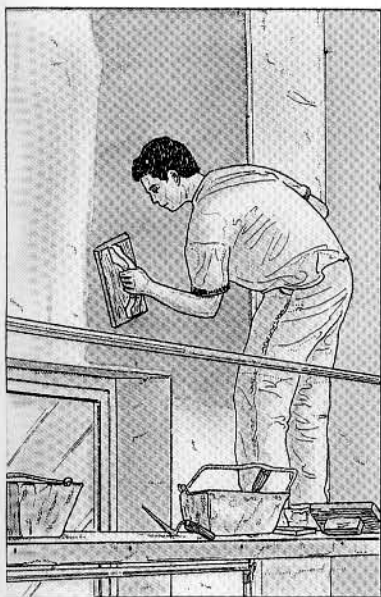
5 et 6. Étalement de la première couche, avec une taloche en bois.
