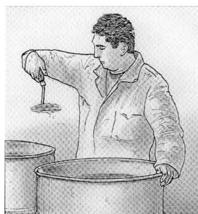
14. Vérification de la couleur du mortier de chaque bidon avant de le tamiser.
