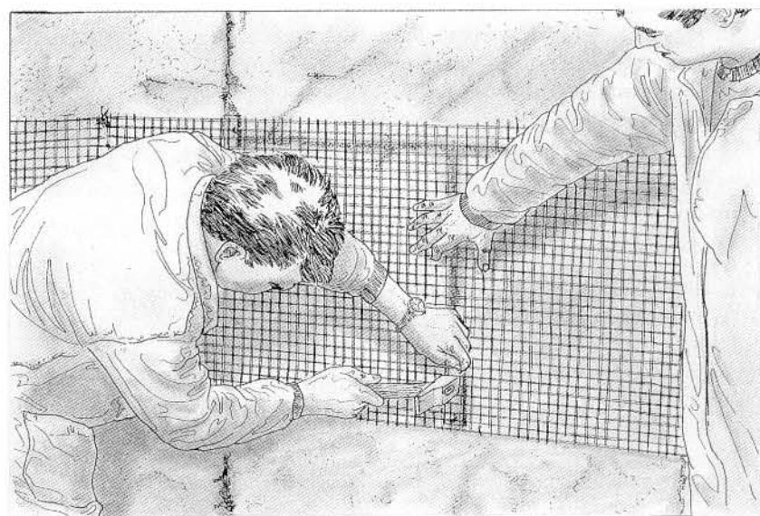
9. Clouage des crochets de fixation de la grille sur les chevilles en bois.
