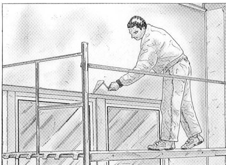
2. Élimination, à la lisseuse, des particules de mortier mixte qui n'ont pas adhéré au mur.
