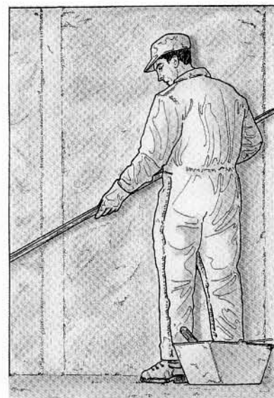
16 et 17. Nivelage de la surface, en passant la règle horizontalement, verticalement et en diagonale.
