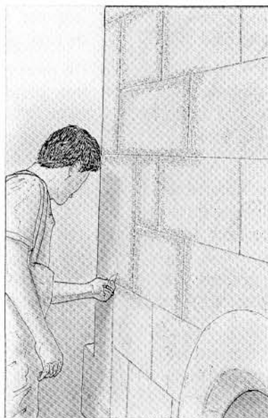
3. Grattage vertical à la lame de scie.
