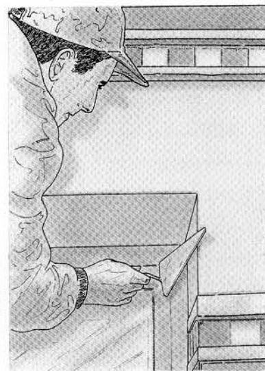
10. Profilage des angles à la lisseuse.
