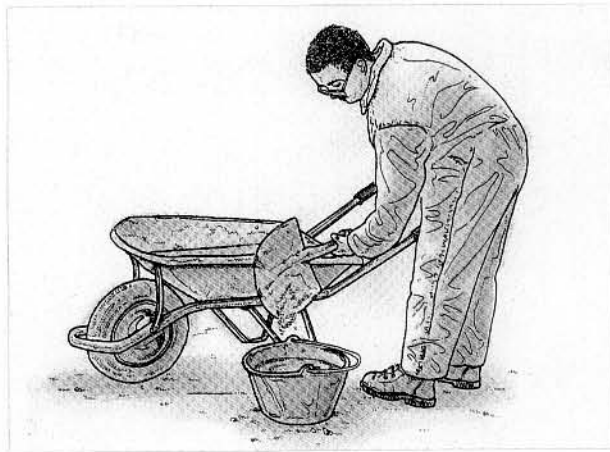
5. Transfert du mortier de la brouette à l'auge.
