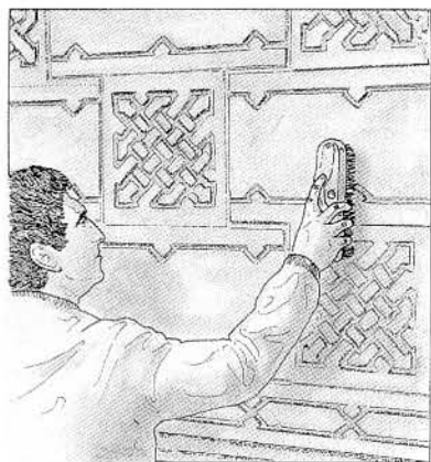
1. Nettoyage du mur avec une brosse à balai.
