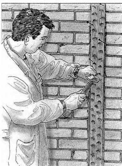
3. Pose des clous en zigzag pour fixer la corde ou le fil de fer.
