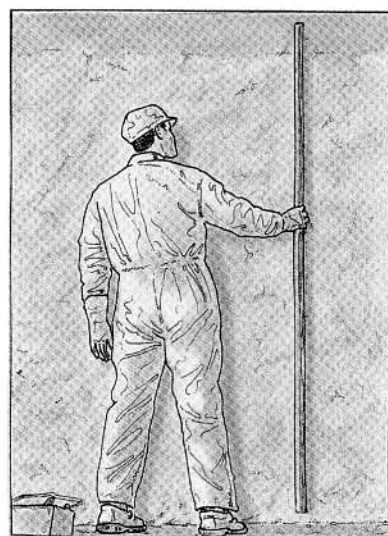
8. Élimination de l'excès de mortier avec la règle.
