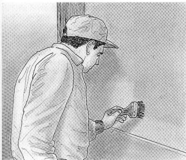
4. Lavage de l'enduit de surface avec un spalter.
