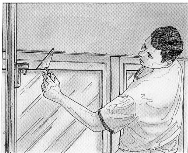
30. Finition des arêtes à la lisseuse.
