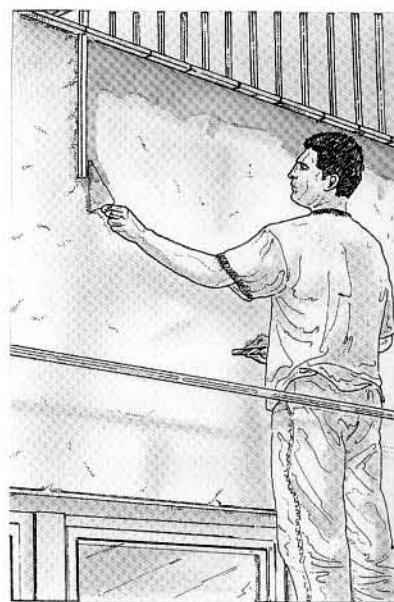
4. Application de la pâte, avec une lisseuse, là où la taloche accède difficilement.
