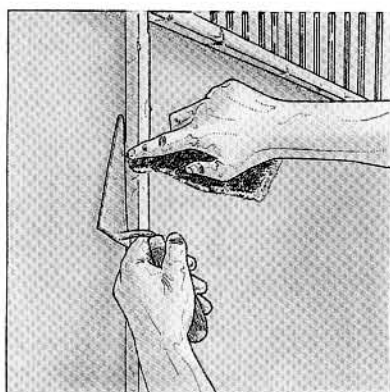
42. Nettoyage des autres éléments à la laine d'acier.
