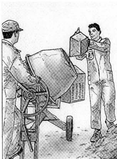
1. Versement de l'eau dans la bétonnière.
