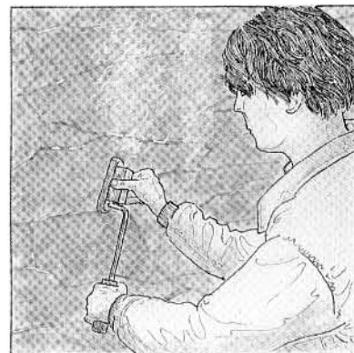
9. Lustrage du stuc avec un fer à dégrossir.
