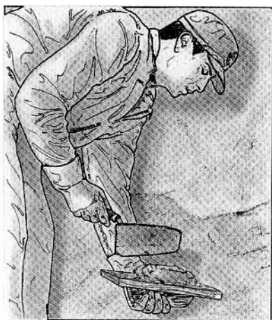
18. Pose de l'avant-dernière couche à l'aide d'une truelle carrée.
