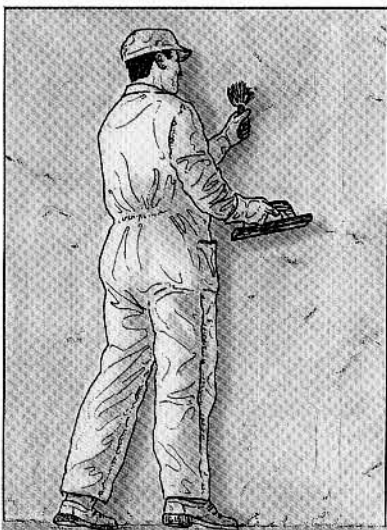
21. Humidification du mur.
