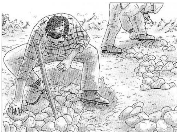
7. Le four est bouché avec des pierres jusqu'à 20 ou 30 cm au-dessus du sol.
