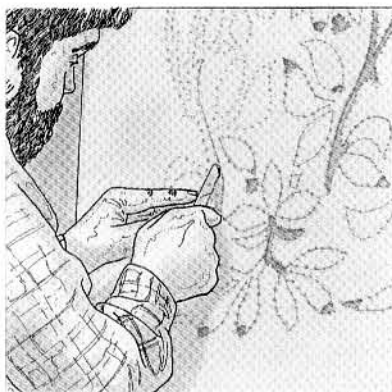
15. Découpe au couteau de l'enduit frais.
