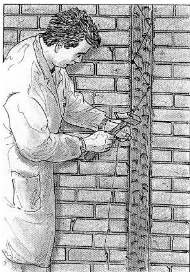
4. Martèlement des clous de fixation.
